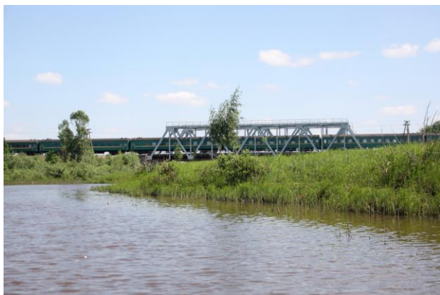
ЖД-мост на линии Мозырь-Овруч.
