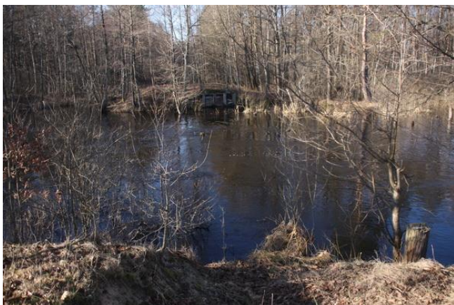
Разрушенный мост бывшей узкоколейки.
