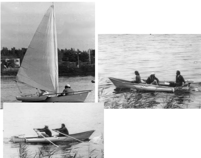
*Испытания тримарана «Янтарь» под парусом, веслом и мотором*
