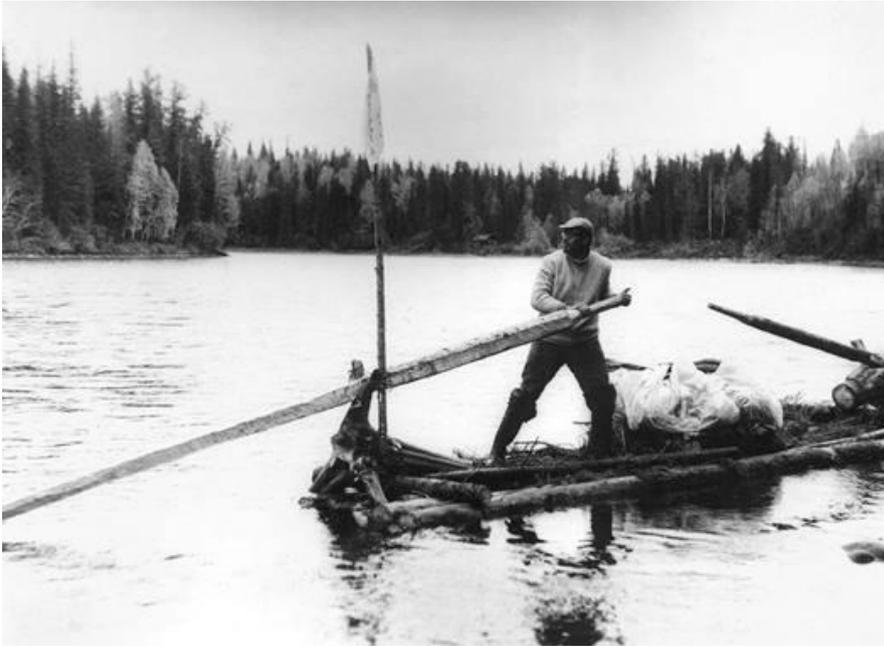
*Опыт постройки пятиместного плота на реке Кизир (Саяны). В качестве подгребниц закреплены на скрутках комли деревьев*
